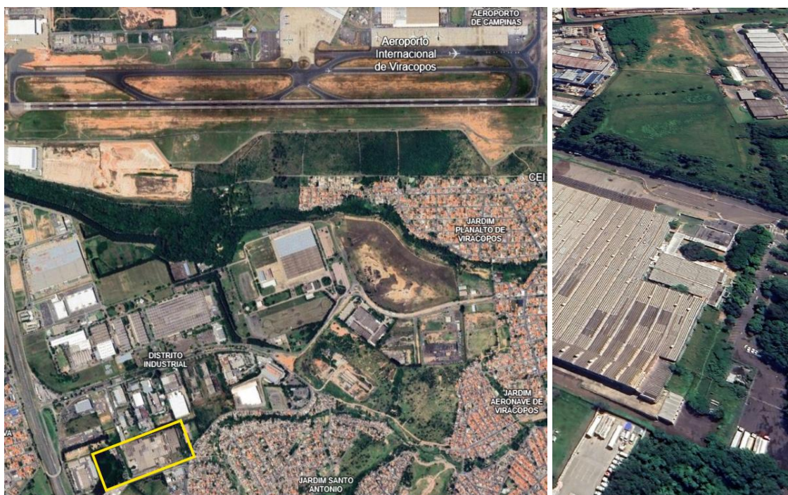
Localização do ativo (em amarelo) nas proximidades do Aeroporto de Viracopos e vista aérea do imóvel.
